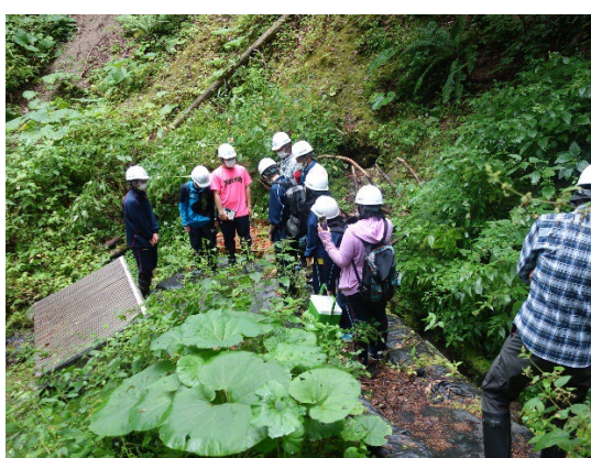
図4 水道利用組合から水道施設の説明
