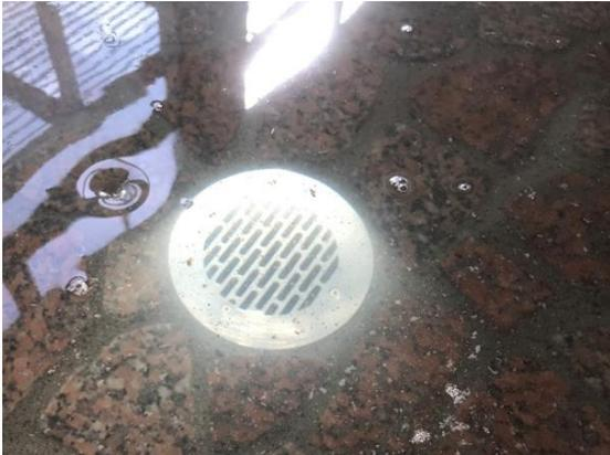
図3 施設Bの洗浄中、循環給湯口から浴槽に汚れが入ってきた様子
