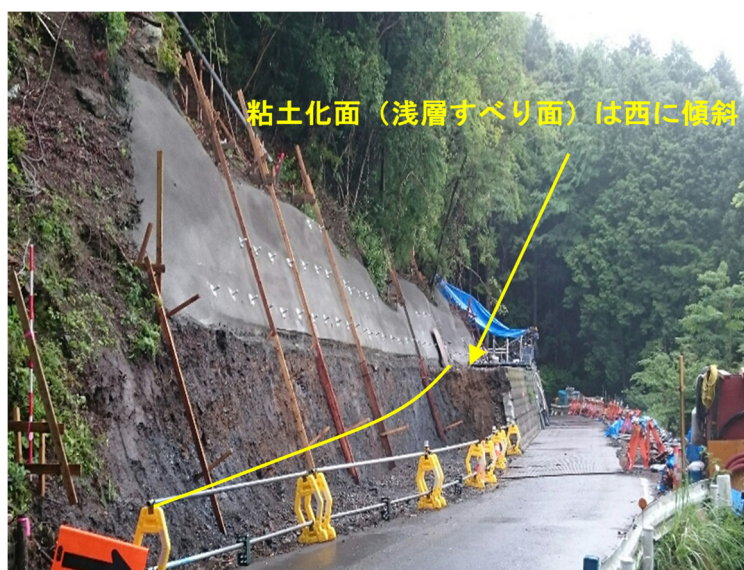
写真-4 区間 1 の 2 次掘削直後の状態
