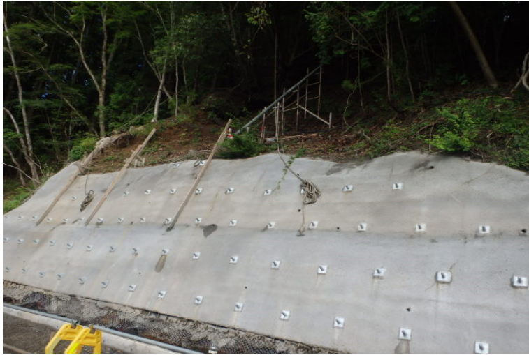
写真-5 区間1 施工完了後の状態
