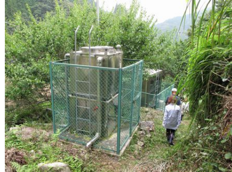
写真 8 沈砂池と配水池
