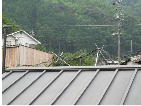
写真6 家屋の上方に設置されている配水管
