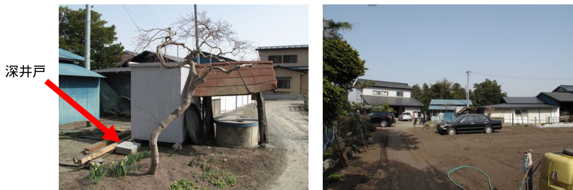
写真10 五戸町 上市川中区第二小規模水道 深井戸
