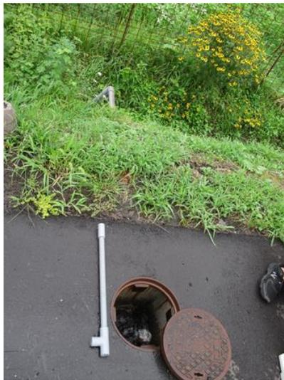
写真2 n 浄水場配水区域末端に設置されている排流装置
