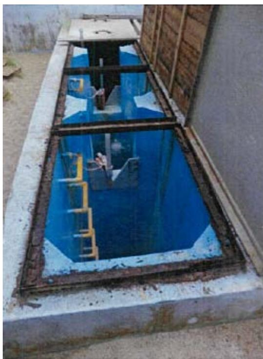
写真 2 緩速ろ過池に設置された錠剤型塩素剤の接触器具<sup>1)</sup>
