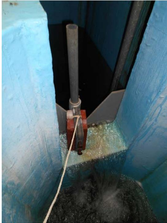
写真 3 緩速ろ過池に設置された錠剤型塩素剤の接触器具(拡大)<sup>1)</sup>
