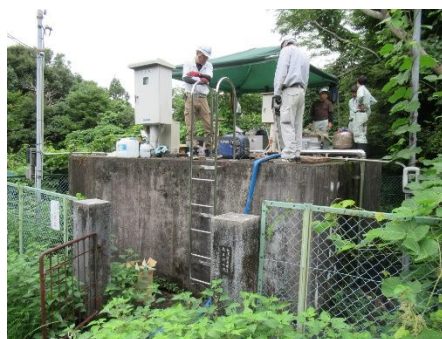
D) 配水池外観
