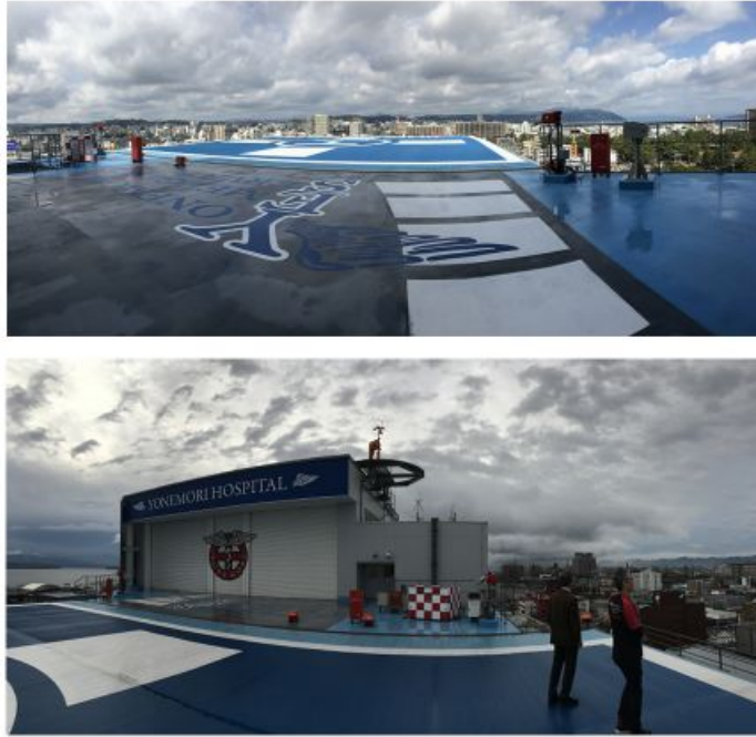
図8 米盛病院屋上ヘリポートと格納庫、給油施設
