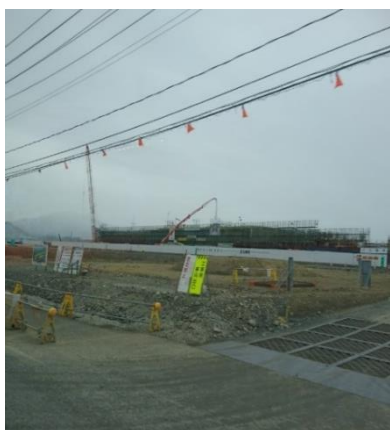
近くに建設中の市立高田小学校。 (平成 31 年秋完成予定)
