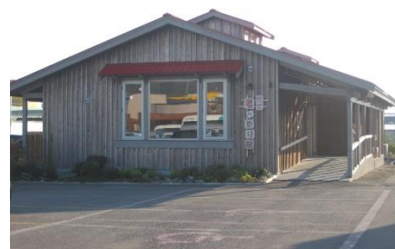
事業所の外観（下は「湯ったり館」）
