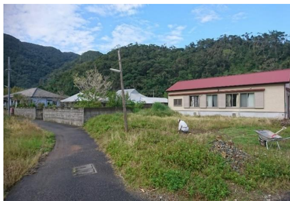
少し離れたところにある作業棟
