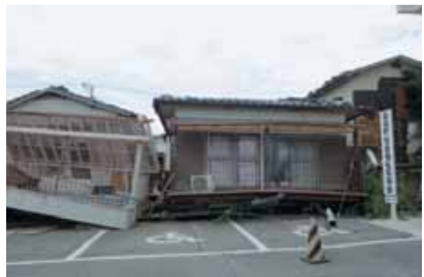
倒壊した家屋（益城町）
