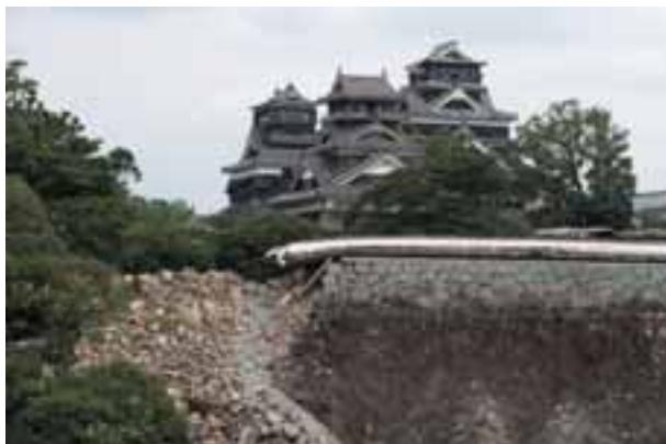
大きな被害を受けた熊本城
