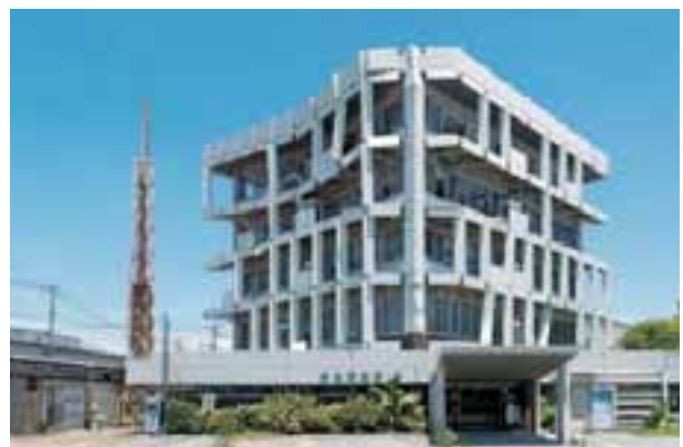
倒壊寸前の宇土市役所
