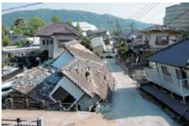
倒壊した家屋（益城町）
