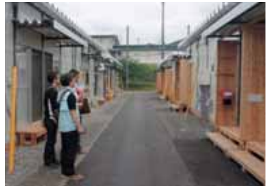
【応急仮設住宅を視察】
