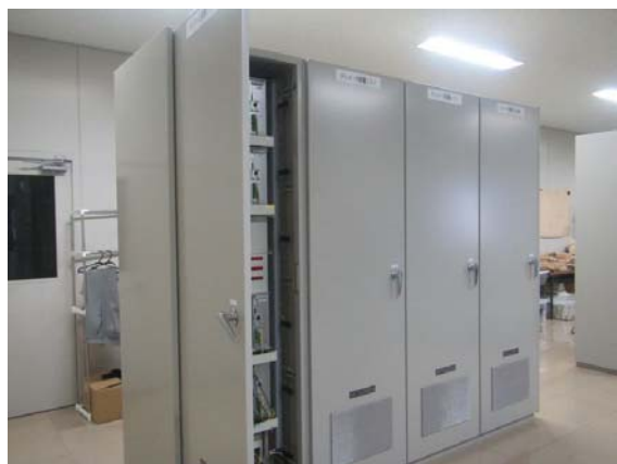
① 自動水質測定装置用テレメータサーバー (Mt社) : Fg浄水場
