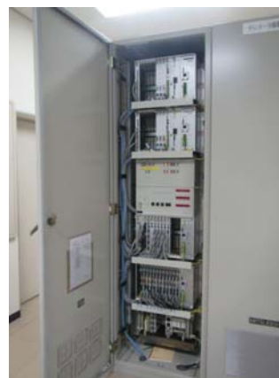
① 自動水質測定装置用テレメータサーバー (Mt社) : Fg浄水場
