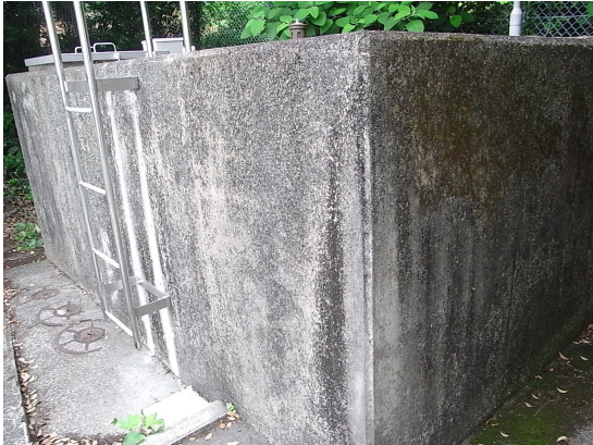
A) A 配水池外観
