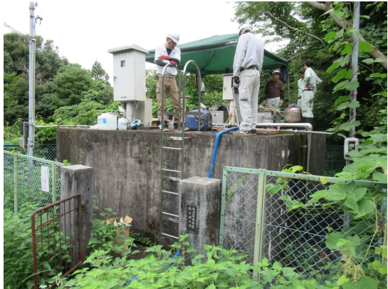
B) B 配水池外観
