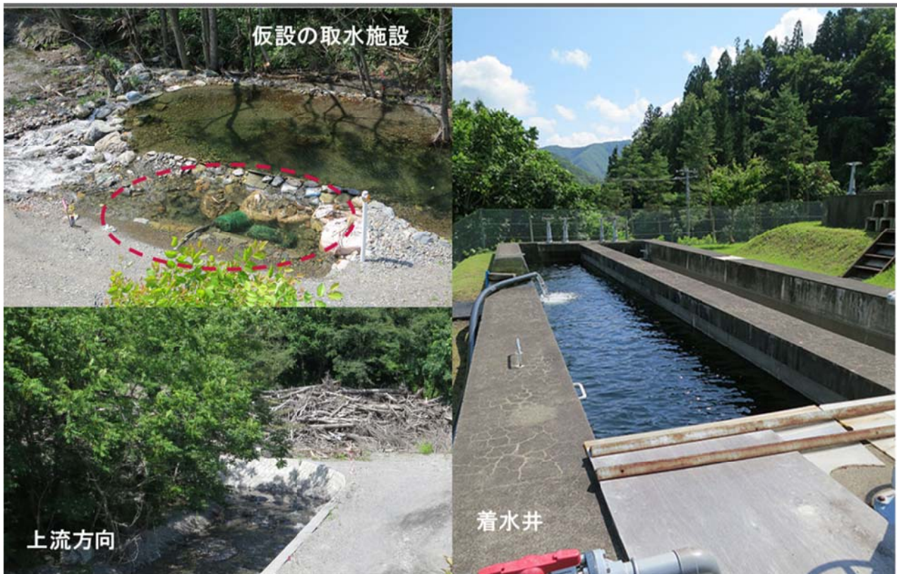
図 2 二升石簡易水道－松橋浄水場
