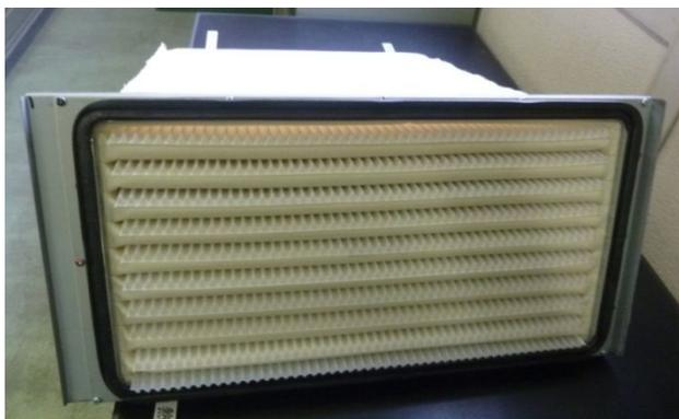
図3-13 ろ布の構造 下流側からの写真
