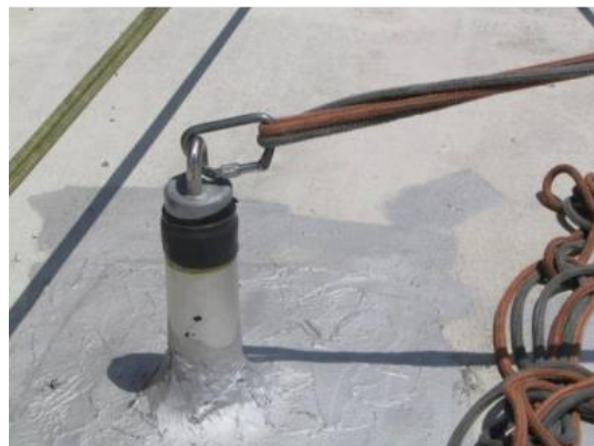
写真-2 安全帯取り付け金具 6)
