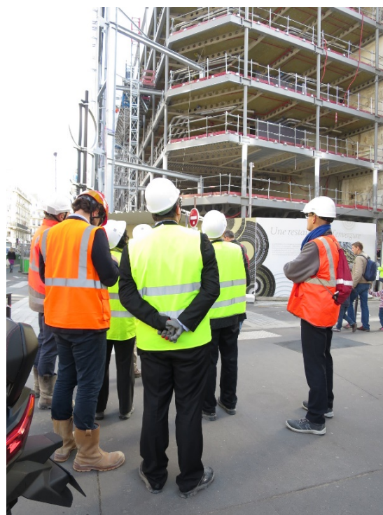
図-6 ビルのリニューアル工事現場
