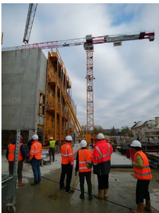
図-5 ショッピングセンターの拡張工事現場
