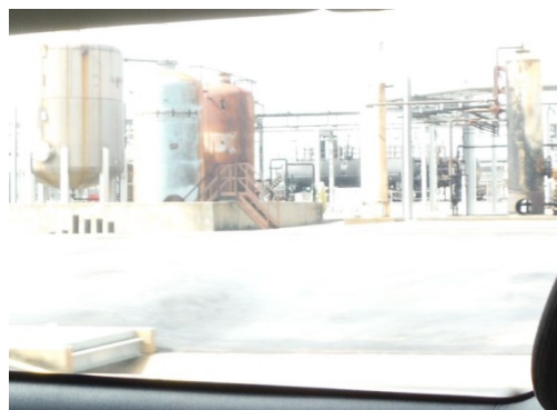
図 5 実際の化学プラントを模擬した訓練施設
