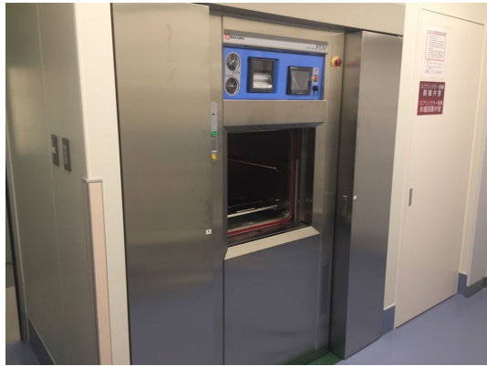
写真 8 . 感染症病室に隣接して配備された オートクレーブ
