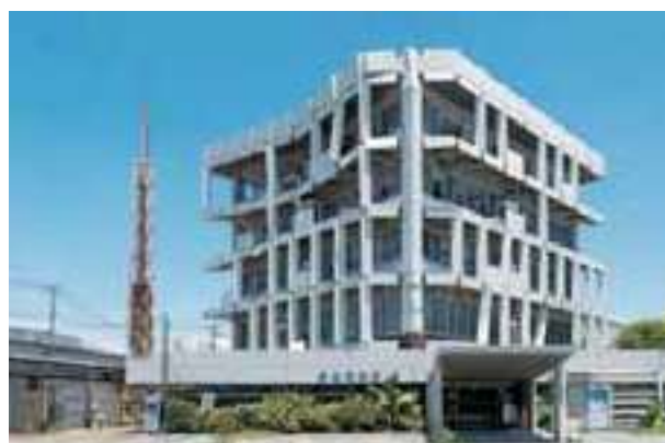
倒壊寸前の宇土市役所
