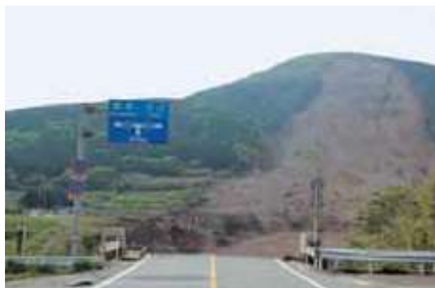
山腹崩落（南阿蘇村）
