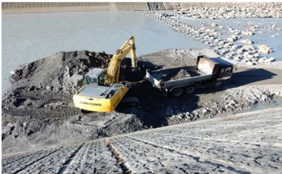
図-8 貯砂ダムに堆積した火山噴出物の撤去状況 (2015年2月4日)
