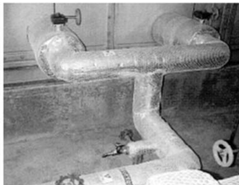
② 給水管に蛇口を付け給水
