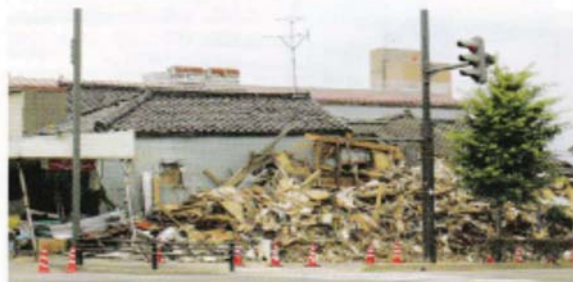
▲ 柏崎市の被害状況。地震動に耐えきれず崩壊した古い家屋。
