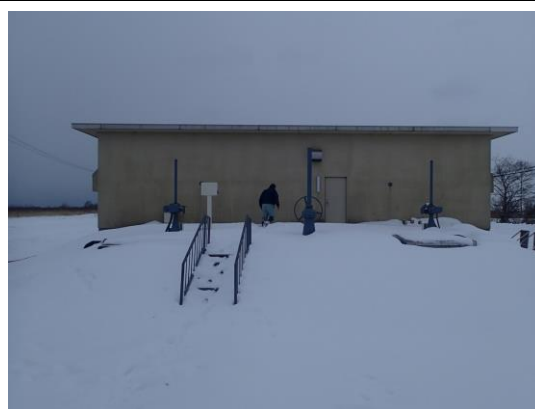
Iw 導水ポンプ場（無人施設）
