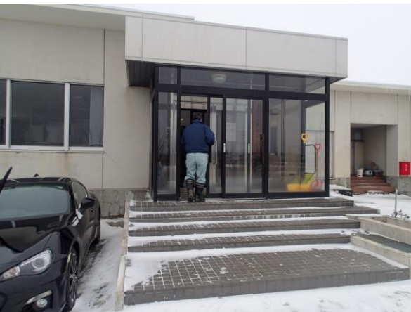
Kz 送配水ポンプ場
