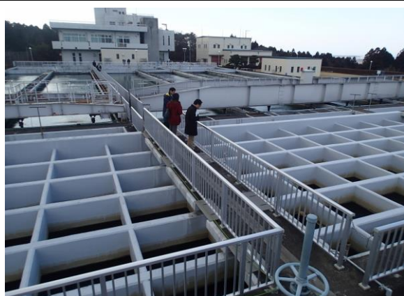
①Hh 浄水場（上下流式フロック形成池）
