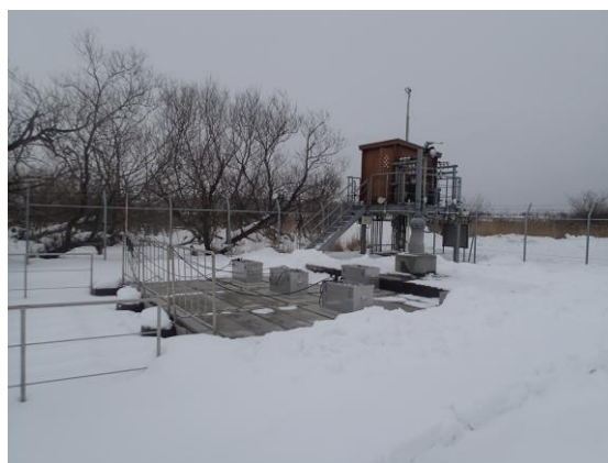
アイスジャム対策用導水渠部赤外線ランプ
