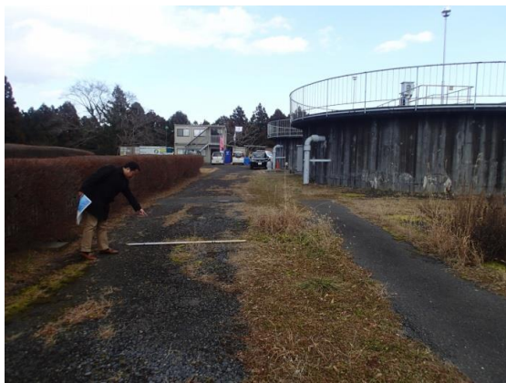
⑦配水池流量計室を出た後（検2）
