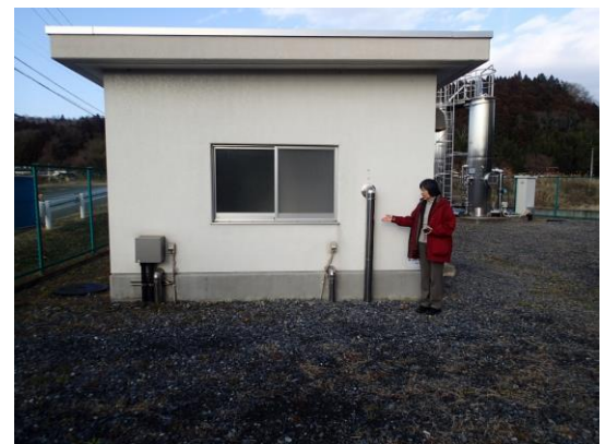
⑪Rd 浄水場（紫外線処理設備設置スペース）
