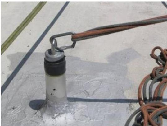
写真-2 安全帯取り付け金具<sup>6)</sup>
