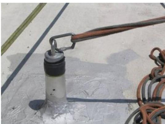
写真-1 安全帯取り付け金具<sup>1)</sup>
