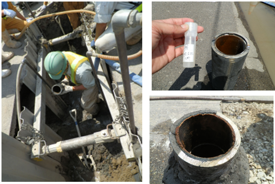
図4 布設替え工事と採取（表4の試料1、2に対応）
