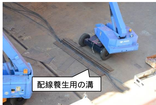
写真2 配線養生用の溝
