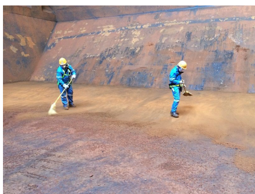
図 5.22 船底での清掃作業状況（その 1）
