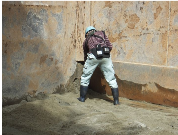
図 5.10 船底での清掃作業状況（その1）
