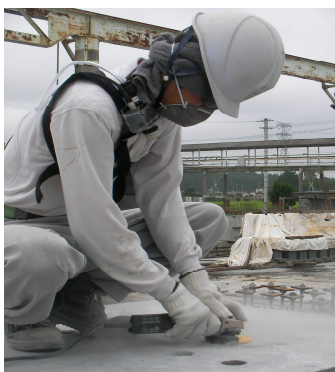
図 1.2 コンクリートに対する研磨・ばり取り作業の様子
