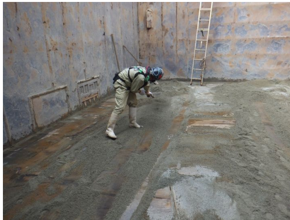
図 5.11 船底での清掃作業状況（その2）
