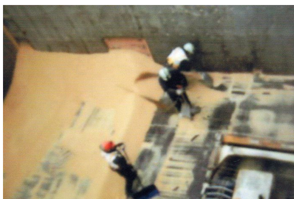
図 5.25 船底での清掃作業状況 (その2)
