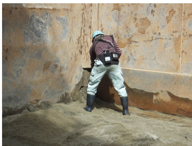
図 3.11 船底での清掃作業状況（その 1）
