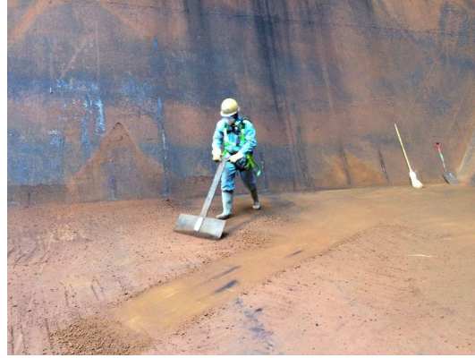
図 3.24 船底での清掃作業状況（その2）
