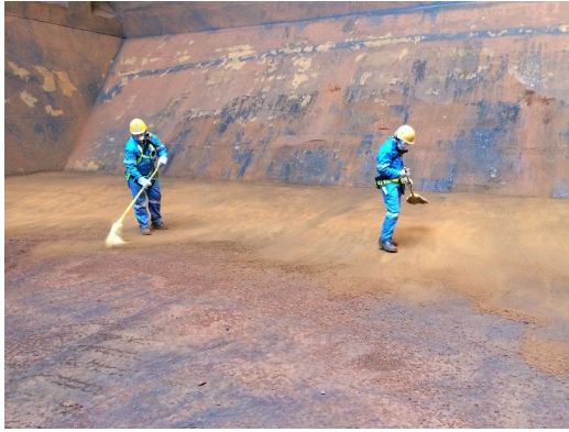
図 3.23 船底での清掃作業状況（その1）
