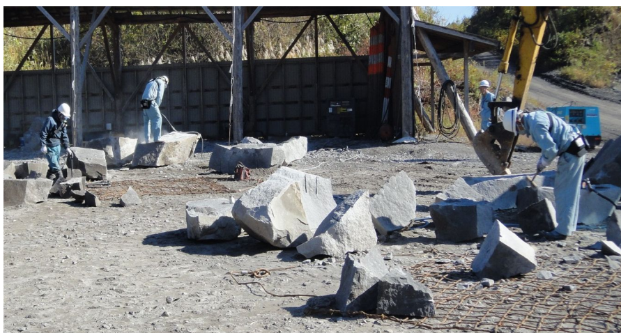
図 2.8 作業場全体の作業風景（その3）
