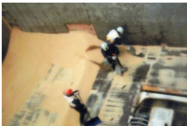
図 3.26 船底での清掃作業状況（その 2）
