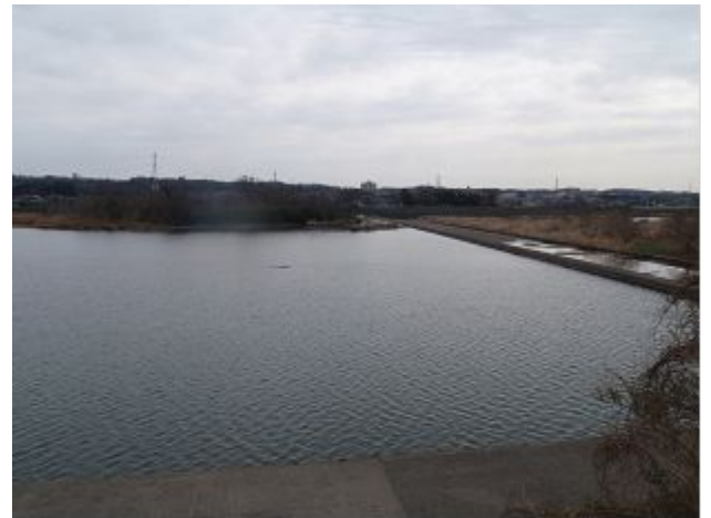
図 6-2 2014年3月26日の磯部頭首工 写真
