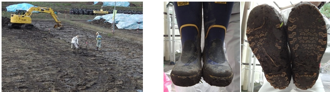
図 III.4 除染作業現場の様子と、最大放射能が観測された長靴 (農地での除染作業に使用された) への土の付着の状態
