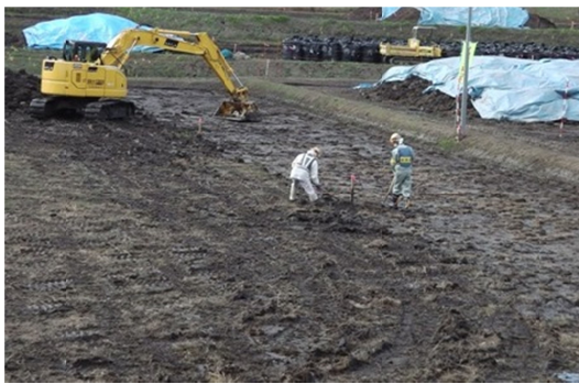
図9 除染作業現場の様子
