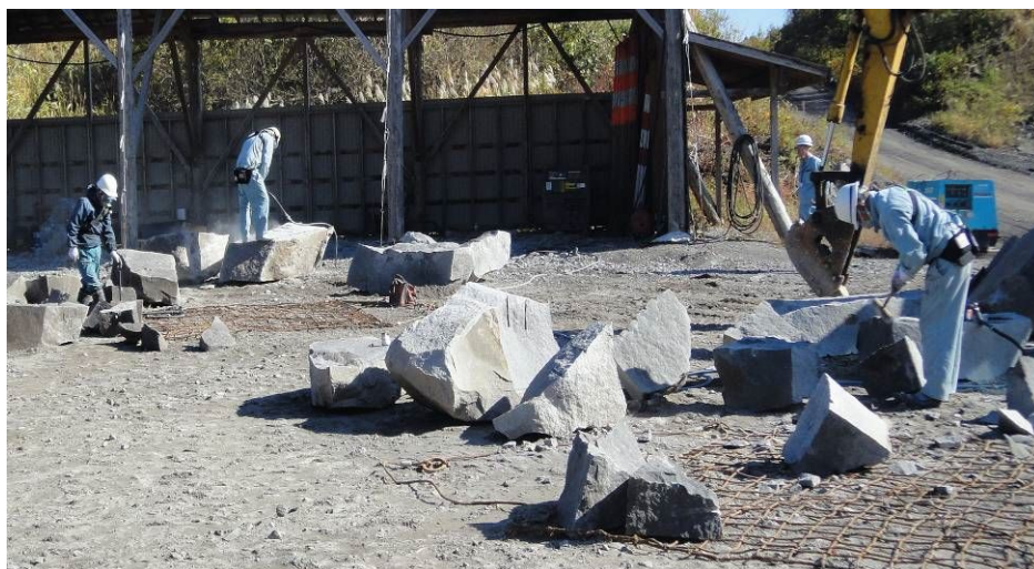
図 2.7 屋外の鉋物等破砕作業風景（その 3）
