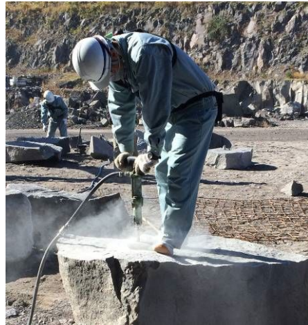
図 2.6 屋外の鉋物等破砕作業風景（その 2）
