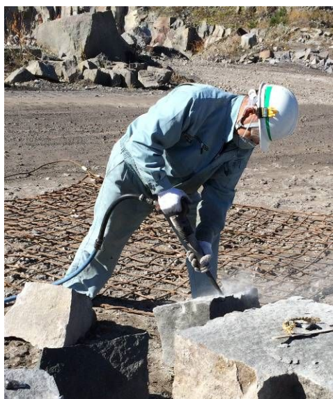
図 2.9 屋外の鉋物等破砕作業風景（その 5）
