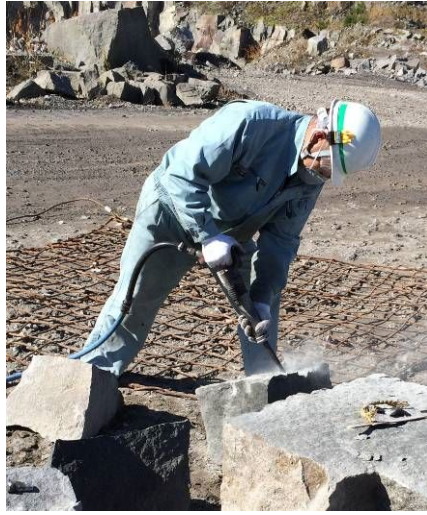
図 2.5 屋外の鉋物等破砕作業風景（その 1）
