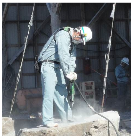
図 2.8 屋外の鉋物等破砕作業風景（その 4）
