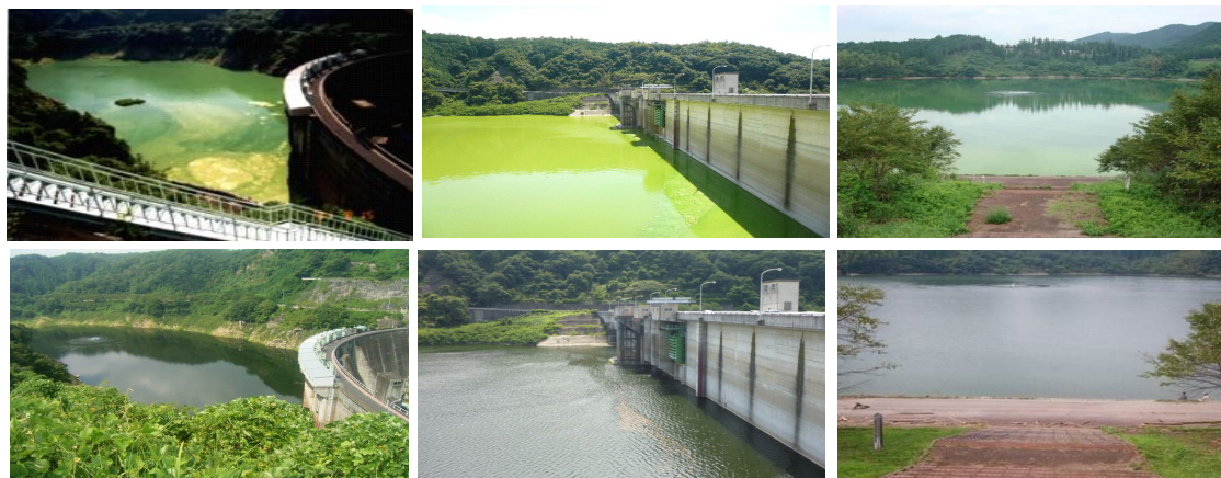
写真1 曝気循環設備増設前（上）と、増設後（下）のダム貯水池の状況（左から B、C、F ダム）
