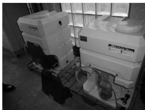
図 25 二段凝集処理設備の設置事例
