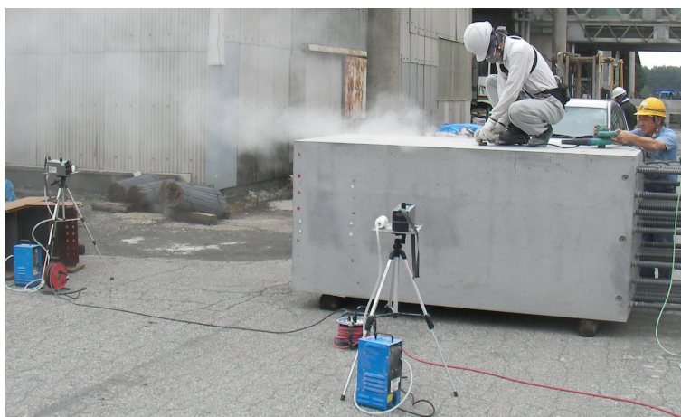
図 1.3 コンクリートに対する研磨・ばり取り作業の測定
