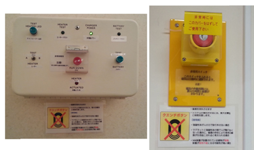
図 7 実際の使用例 異なるデザインのクエンチボタンであるが、統一シールを掲示することによりボタンの機能が明確になる。
