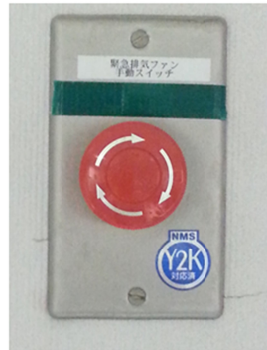
図3 緊急排気ボタン(スイッチ)
