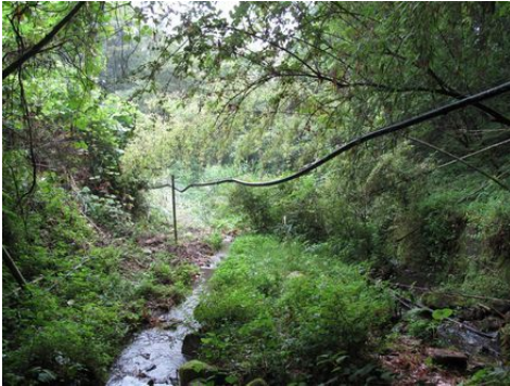
写真4 浄水施設までの導水管
