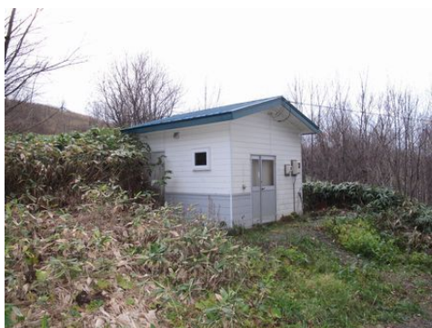
写真 15 西麓郷専用水道 浄水処理施設
