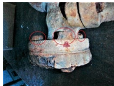
図1 現地調査でのフランジ継手
