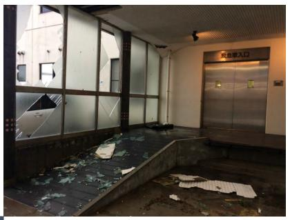
【施設被害】 窓ガラス破損 窓枠落下 雨吹き込みによる浸水 室外機破損 外壁・天井破損
