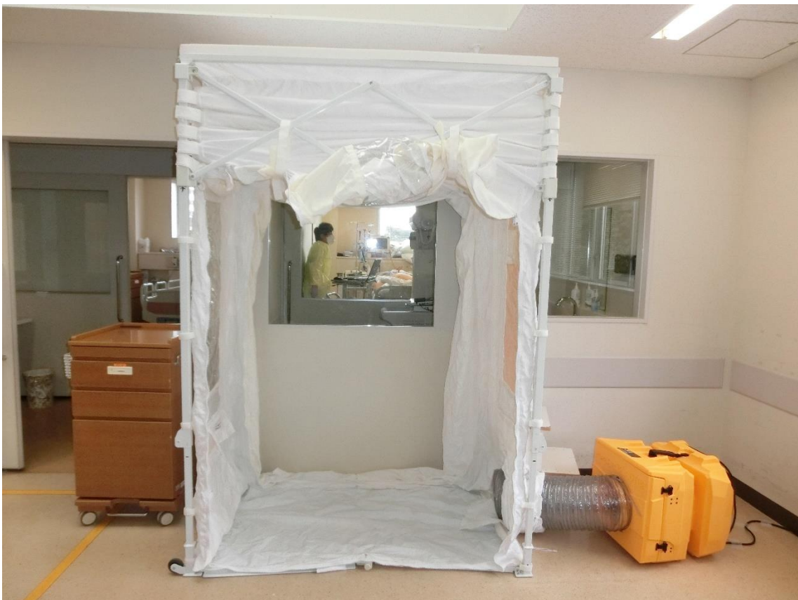
20. 簡易陰圧トンネル (O)
