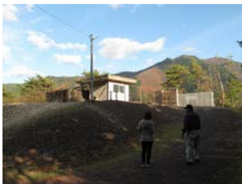
写真1 風屋地区簡易水道施設
