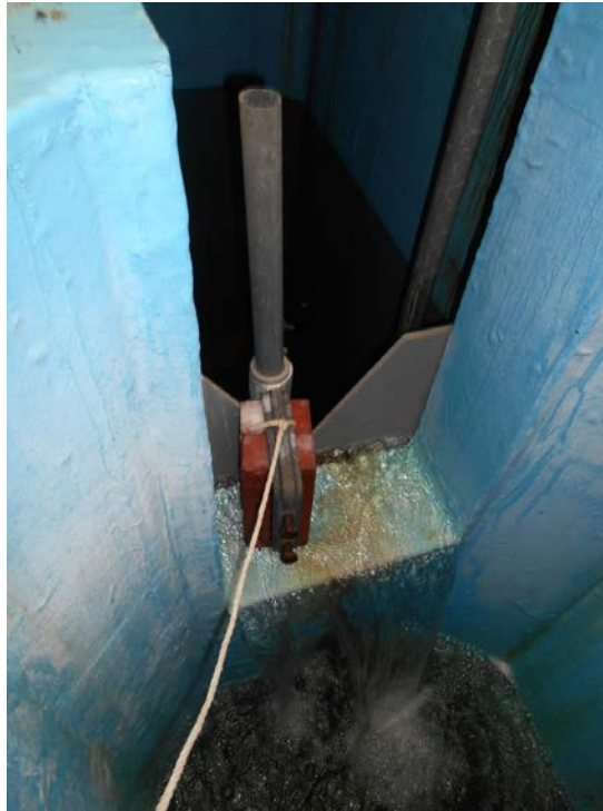
写真 3 緩速ろ過池に設置された錠剤型塩素剤の接触器具(拡大) 1)
