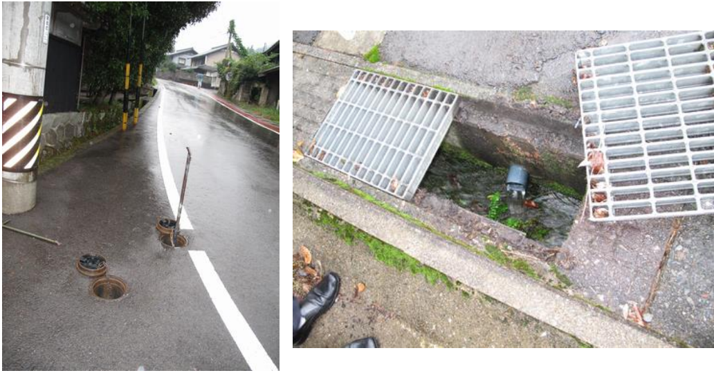
写真1 「排泥作業」の様子（お盆前に行う実際の作業を再現したもの）
