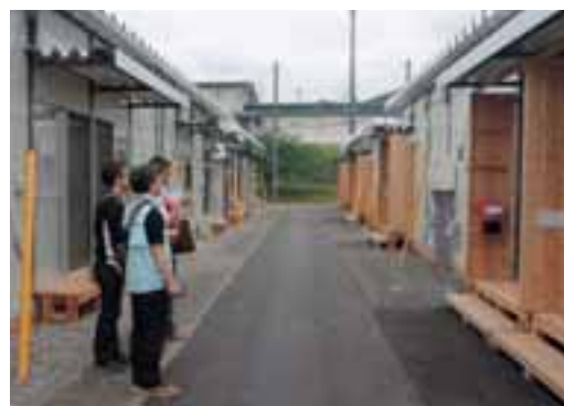
【応急仮設住宅を視察】
