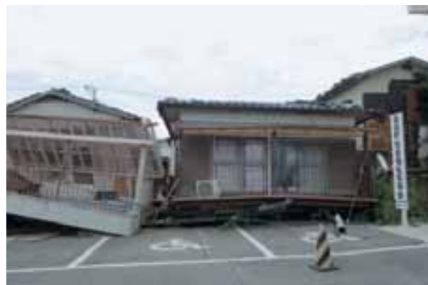
倒壊した家屋（益城町）
