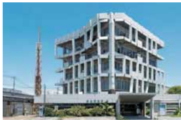
倒壊寸前の宇土市役所
