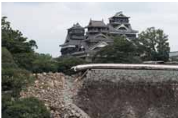
大きな被害を受けた熊本城
