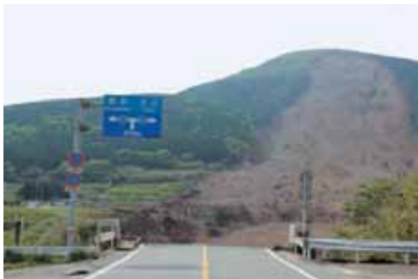
山腹崩落（南阿蘇村）
