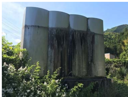
受水槽タンク（ステンレス製）
