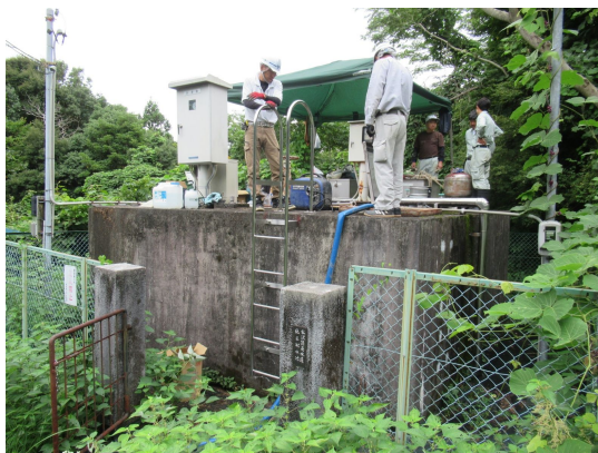
B) B 配水池外観
