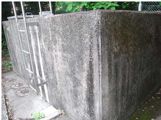
A) A 配水池外観
