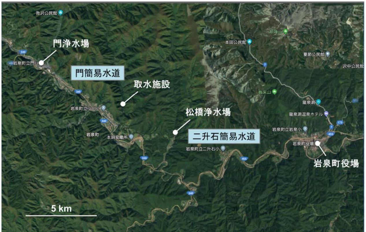
図 1 岩泉町における損壊水道施設の視察（小本川流域）
