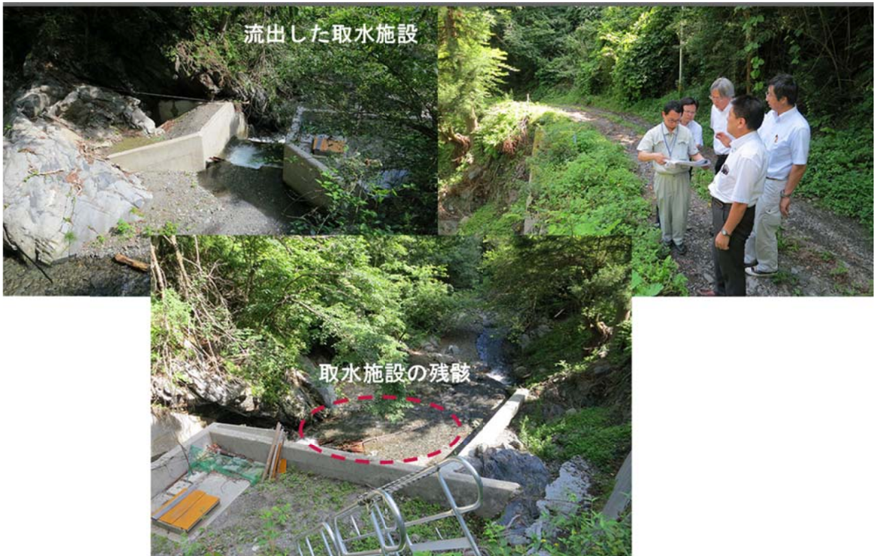
図3 門簡易水道一袋綿浄水場取水施設
