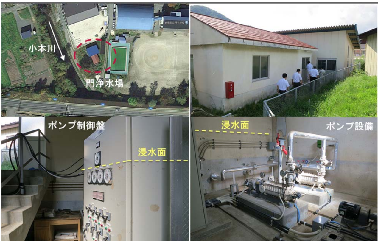
図4 門簡易水道一門浄水場
