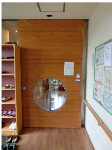
向こう側が見える小窓は、車いすの子どもたちの視線の高さに合わせて設計されている。
