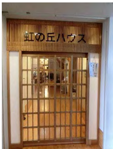
向こう側が見える小窓は、車いすの子どもたちの視線の高さに合わせて設計されている。
