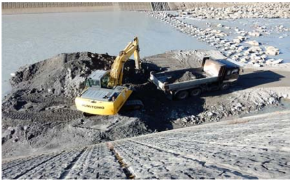
図-8 貯砂ダムに堆積した火山噴出物の撤去状況 (2015年2月4日)
