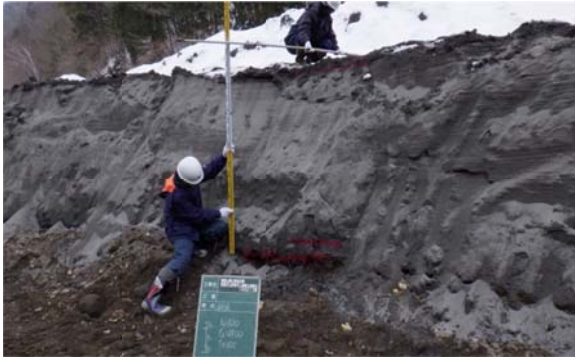
図-7 貯砂ダムに堆積した火山噴出物
