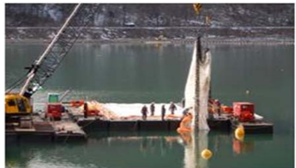
図-6 沈下式汚濁防止フェンス (幅 140m, 高さ 10m)
