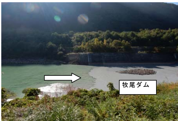
図-3 貯水池流入端に堆積した火山噴出物の状況 (貯砂ダム地点：2014年9月29日)
