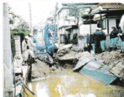
▲水道本管がいたる所で破壊され、懸命な復旧作業が行われたが断水状態が続いた。
