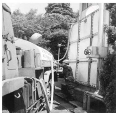
④ 貯水槽に生活水を供給する給水車
