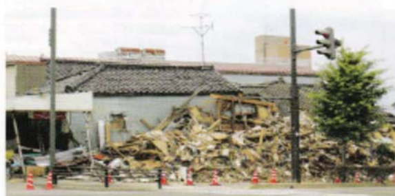
▲ 新潟市の被害状況。地震動に耐えきれず崩壊した古い家屋。
