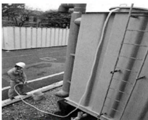
③ サイホン利用しマンホールから給水
