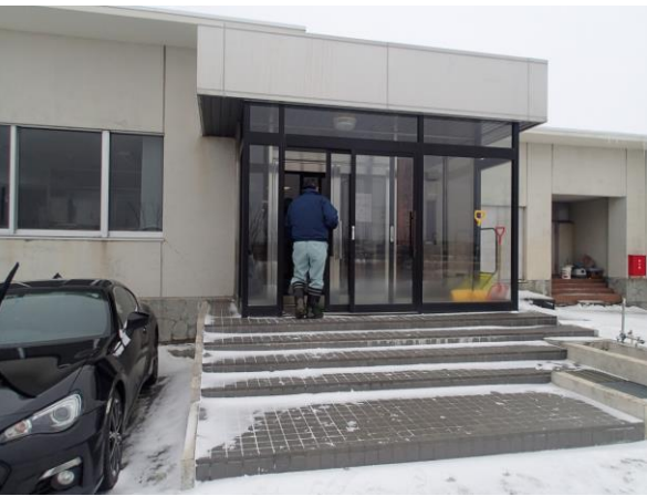
Kz 送配水ポンプ場
