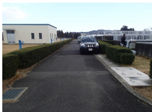
⑥Hh（検1）（ろ過池～浄水池間のスペース）
