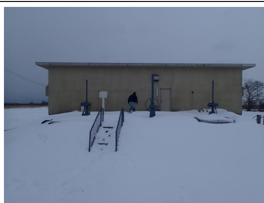
Iw 導水ポンプ場（無人施設）
