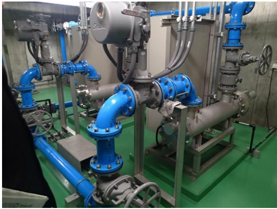
⑬My 水系浄水場-1 (紫外線処理設備)
