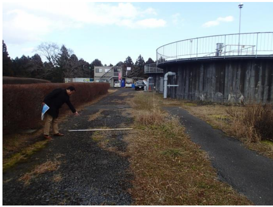
⑦配水池流量計室を出た後（検2）
