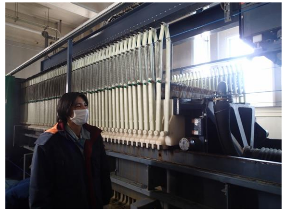
汚泥処理施設③（脱水機：中時間型 8h）
