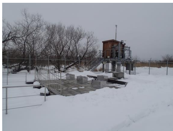
アイスジャム対策用導水渠部赤外線ランプ
