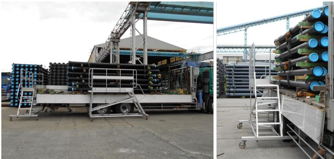
図11．現場で使用されていた荷台から墜落防止対策
