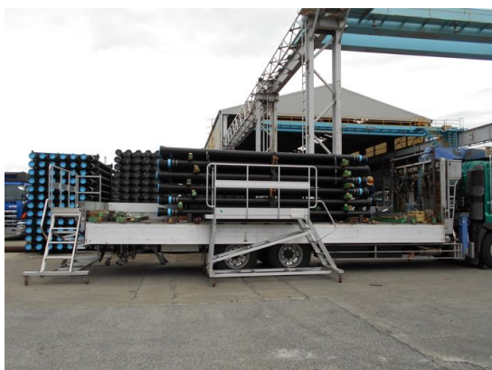
写真-3 荷主庭先据置型の墜落防止設備
