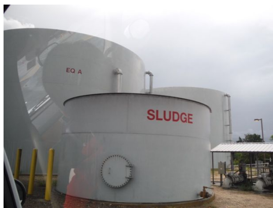
写真-2 実規模のケミカルタンクを模擬した訓練施設
