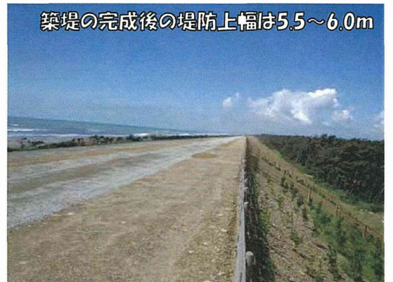
本体施工その1
